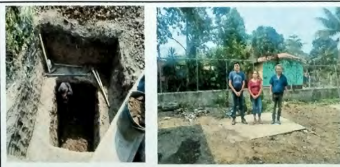
Foto 6: TRABAJOS EXTERIORES. Como adicional se realizo la construccion de una fosa septica. De 2.60 mts x 2.60 mts. 2.850 mts profundidad.
