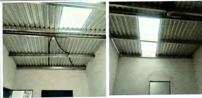
Foto 8: MODULO DE COCINA, -VISTA INTERIOR Estructura de metal a base de costaneras con instalacion de lamina troquelada cal 26. Aplicación de acabado de repello y cernido en muros. Instalacion de unidad de luminaria con cableado y enductado respectivo.
