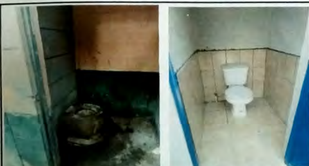
Foto 5: MODULOS SERVICIOS SANITARIOS Vista interior de modulo de sanitario, donde se instalo piso ceramico y azulejo en muros, asi mismo se sustituyo sanitario de concreto por sanitario de pocolana lavable.
