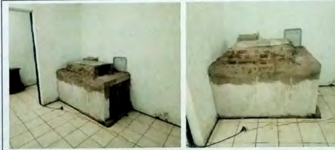
Foto 12: MODULO DE COCINA Construcción de poyeton con base de ladrillo para plancha metalica.
