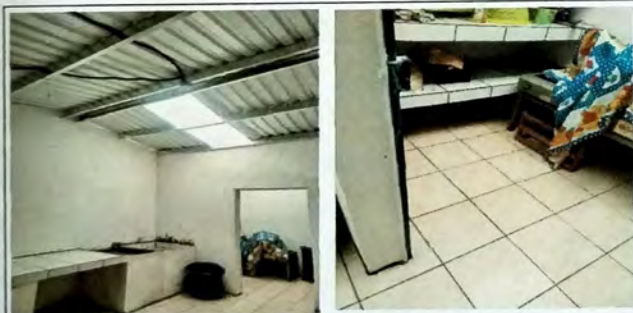
Foto 9: MODULO DE COCINA, MODULO DE COCINA, -VISTA INTERIOR Estructura de metal a base de costaneras con instalacion de lamina troquelada cal 26. Aplicación de acabado de repello y cernido en muros. Aplicación de piso cerámico.
