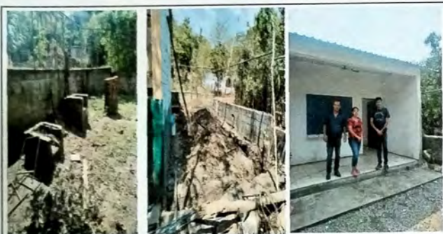
Foto 7: MODULO DE COCINA. Vista Frontal acompañado de presidente de OPF y director del plantel escolar. Area de banqueta al frente y suministro e instalación de puerta de metal para ingreso al modulo y hojas de metal en vano de ventanería para servir la comida.
