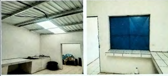
Foto 10: MODULO DE COCINA Vista interior mueble de concreto con aplicación de azulejo en superficie, instalacion de hojas de metal en vano de ventanería.
