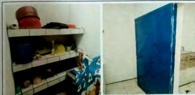
Foto 11: MODULO DE COCINA, Mueble de concreto con aplicación de azulejo en superficie de entrepaños, así mismo la instalacion de puerta metalica en area de bodega.
