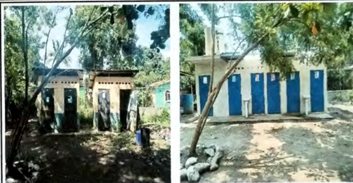
Foto 2: MODULOS SERVICIOS SANITARIOS, Vista Frontal. Acabados en muros, sustitucion de puertas de metal. Cambio de estructura de metal en malas condiciones por estructura nueva a base de costaneras de metal, cambio de cubierta de lamina de zinc en mal estado por lamina troquelada cal 26.
