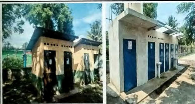
Foto 3: MODULOS SERVICIOS SANITARIOS, Vista Lateralizada. Acabados en muros, sustitucion de puertas de metal. Cambio de estructura de metal en malas condiciones por estructura nueva a base de costaneras de metal, cambio de cubierta de lamina de zinc en mal estado por lamina troquelada cal 26.
